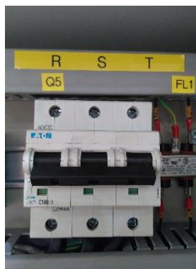
Figura 6 - Disjuntor geral
